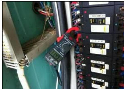
運轉電流測試
