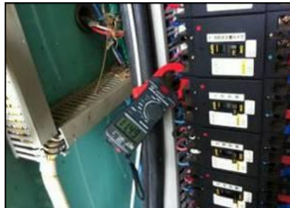
運轉電流測試
